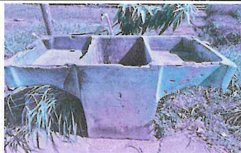
Foto 6: Estado de la pila
