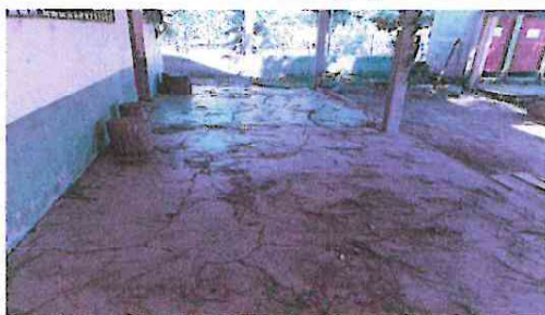
Foto 5: Torta en mal estado corredor de Aula 1 y 2
